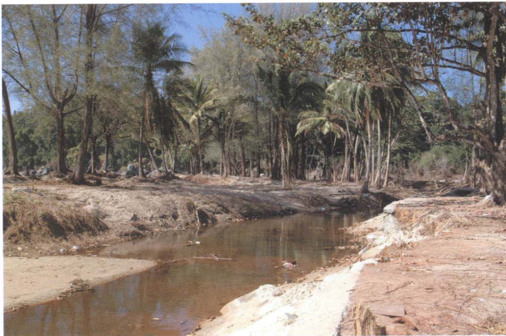
รูปที่ 3-34 การกัดเซาะบริเวณปากคลองบริเวณชายหาดบางเหนียง
