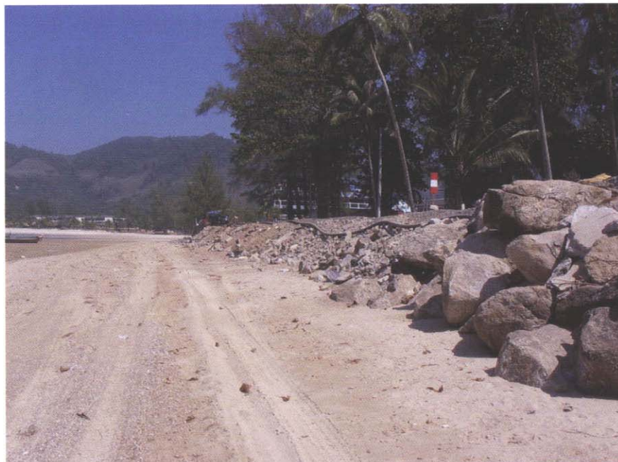
รูปที่ 4-6 การปรับถมทรายบริเวณแนวชายหาดบ้านกมลา
