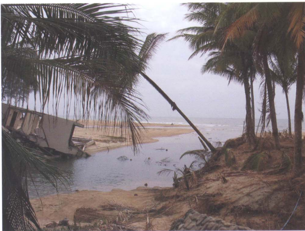
รูปที่ 3-29 การกัดเซาะบริเวณปากทางเข้า lagun บริเวณชายหาดคึกคัก
