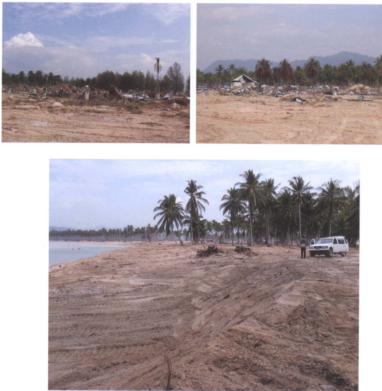
รูปที่ 3-26 การรื้อถอนและปรับพื้นที่บริเวณที่เสียหาย
