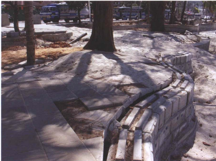
รูปที่ 4-14 ทางเท้าริมชายฝั่งที่ถูกกัดเซาะ
